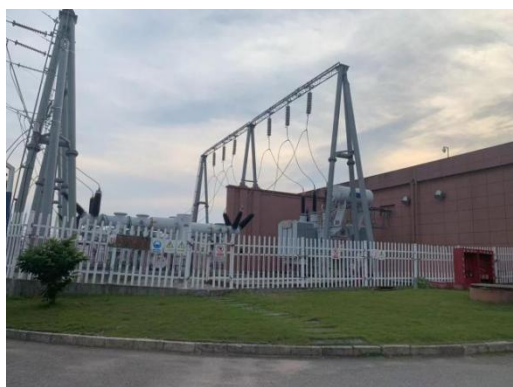
图 6-1 主变全户外布置
